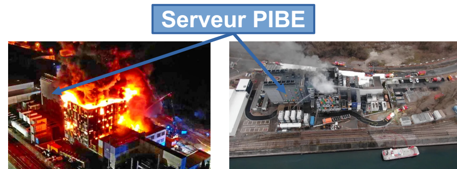
Datacenter d'OVH (Strasbourg - 10/03/2021)
