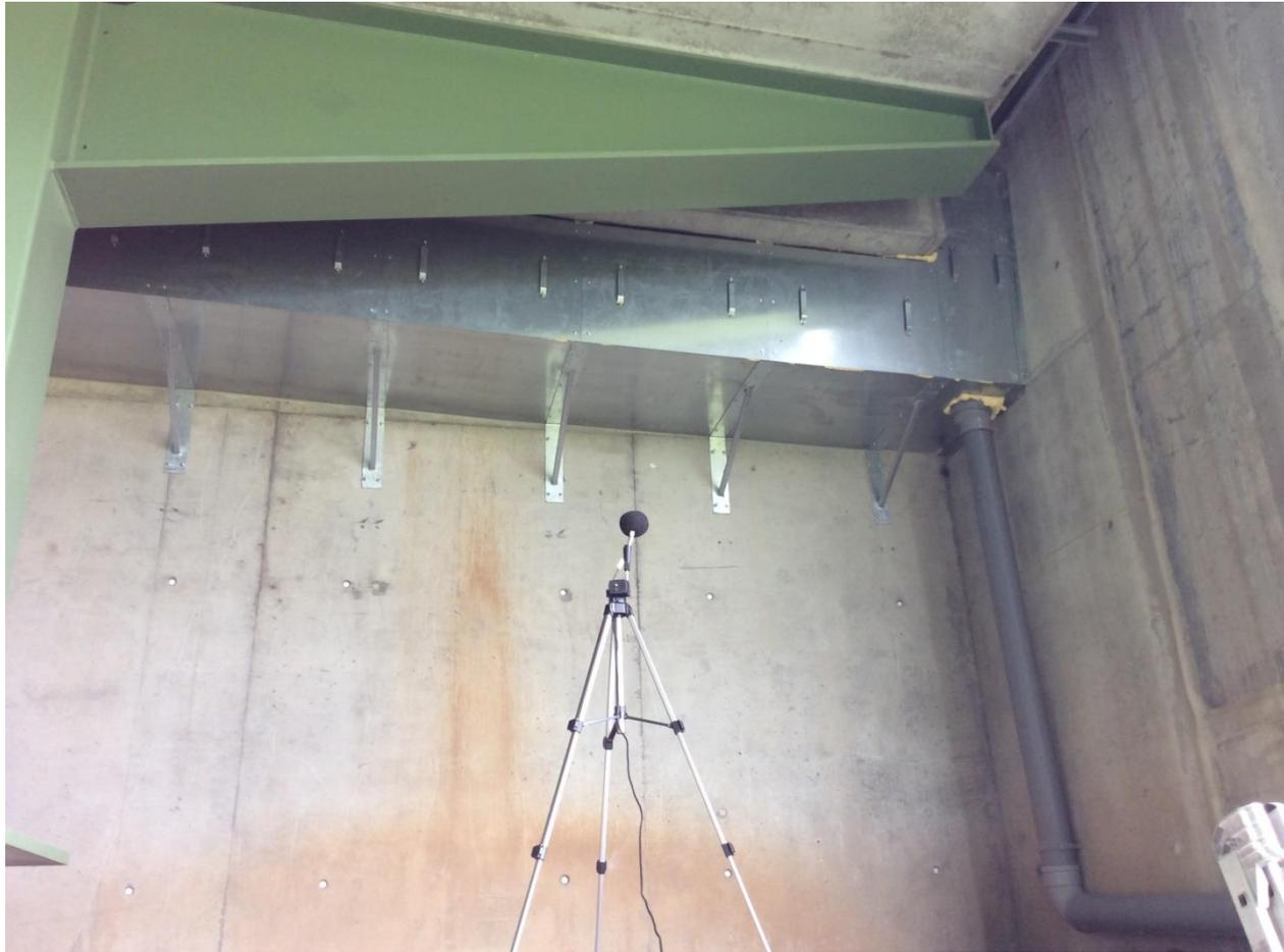
Coffre en acier galvanisé au plus proche de la gouttière avec 10cm de mousse polyuréthane
