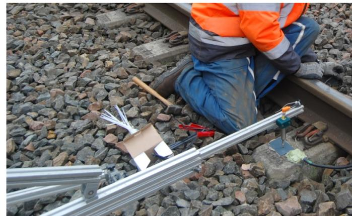
Installation d'un LVDT attaché à un poteau caténaire (LAMAS-LOPEZ, 2014)
